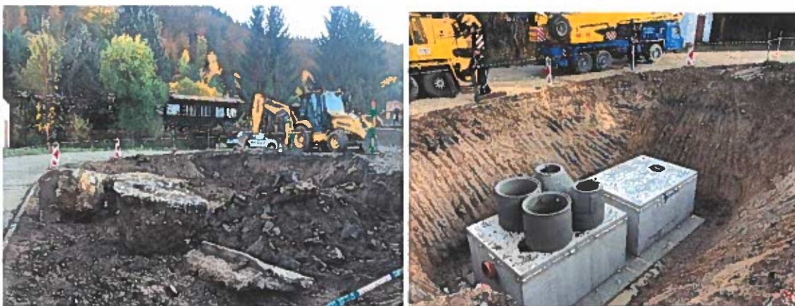
Rekonštrukcia dažďovej kanalizácie v prevádzke BB
