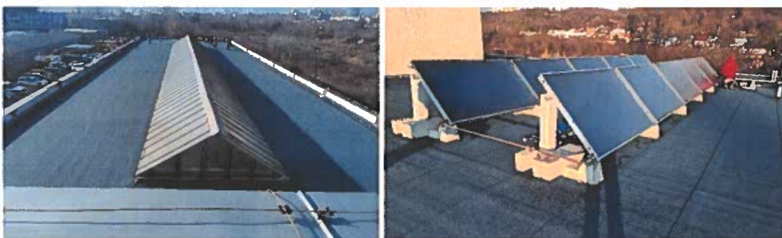
Rekonštrukcia strechy a osadenie slnečných kolektorov v prevádzke Košice
