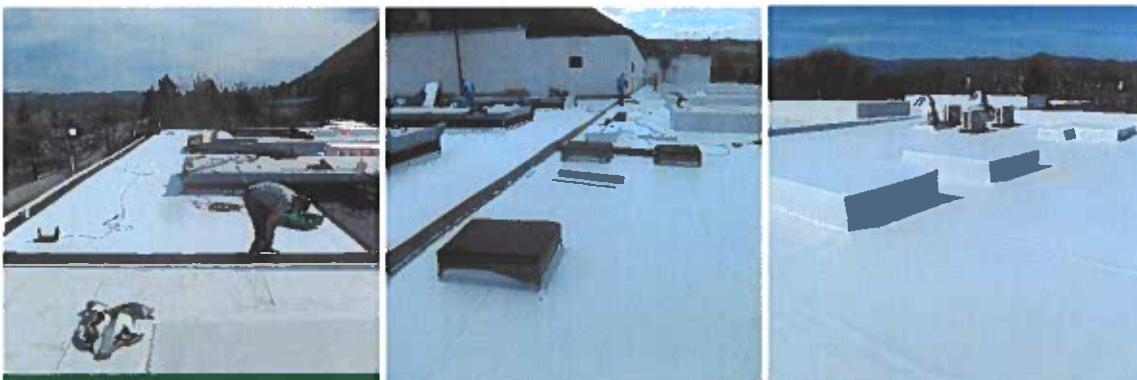
Rekonštrukcia a zateplenie strechy v prevádzke BB
