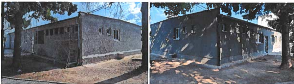
Nákladná dielňa v prevádzke Košice pred rekonštrukciou a po rekonštrukcii
