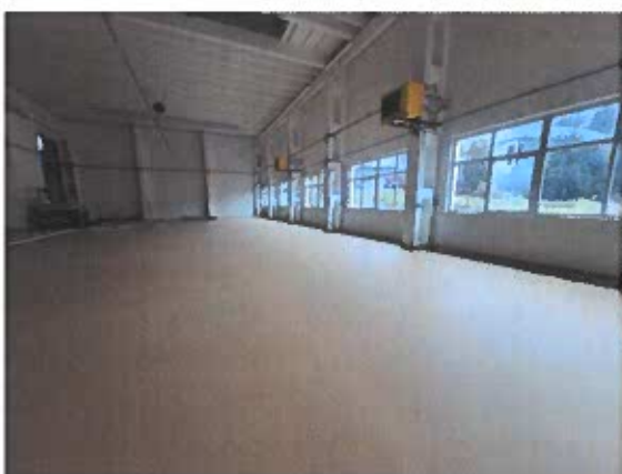
Zrekonštruovaná hala na výrobu TEČ v BB
