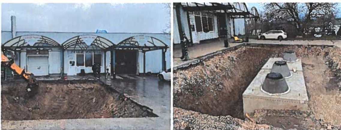
Rekonštrukcia kanalizácie umývarky áut v prevádzke BB
