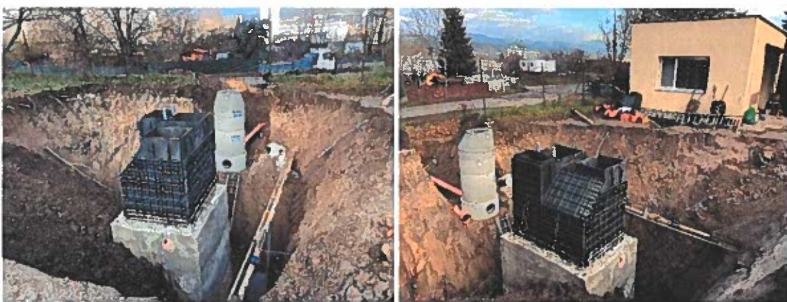
Rekonštrukcia splaškovej kanalizácie v prevádzke BB
