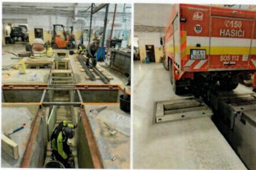
Prestavba nákladnej dielne v Žiline
