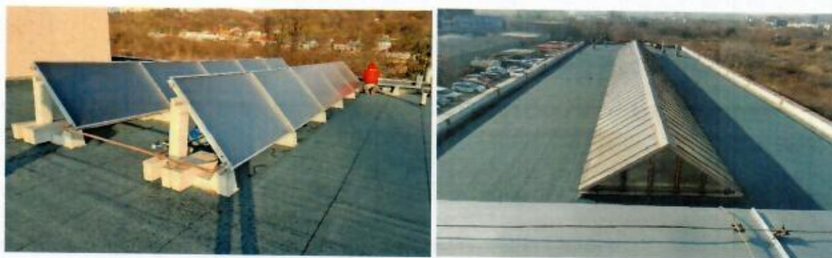
Rekonštrukcia strechy a osadenie slnečných kolektorov v prevádzke Košice
