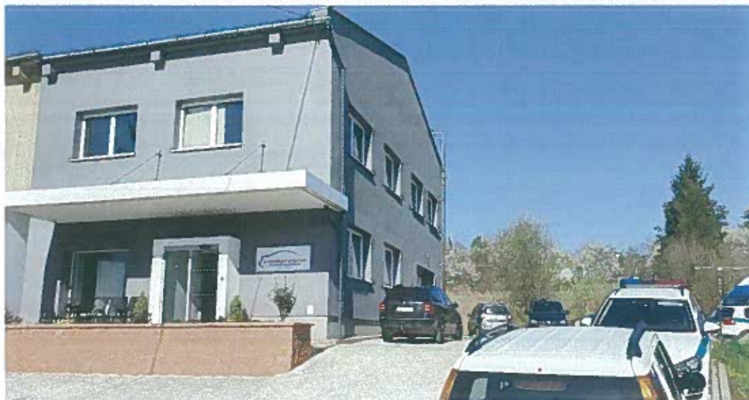
Nové rekonštruované priestory v Prešove
