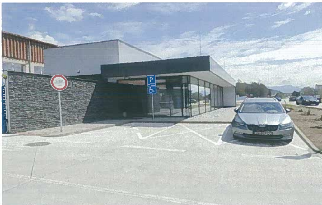
Nová fasáda budovy v Žiline
