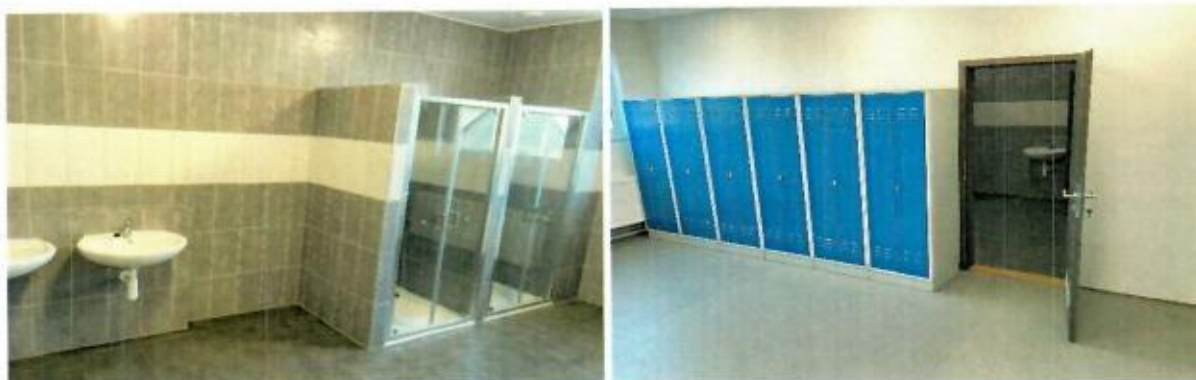
Zrekonštruované sociálne zariadenia a šatne v Banskej Bystrici
